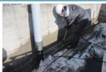
●側溝の汚泥の除去 (提供) 福島市
