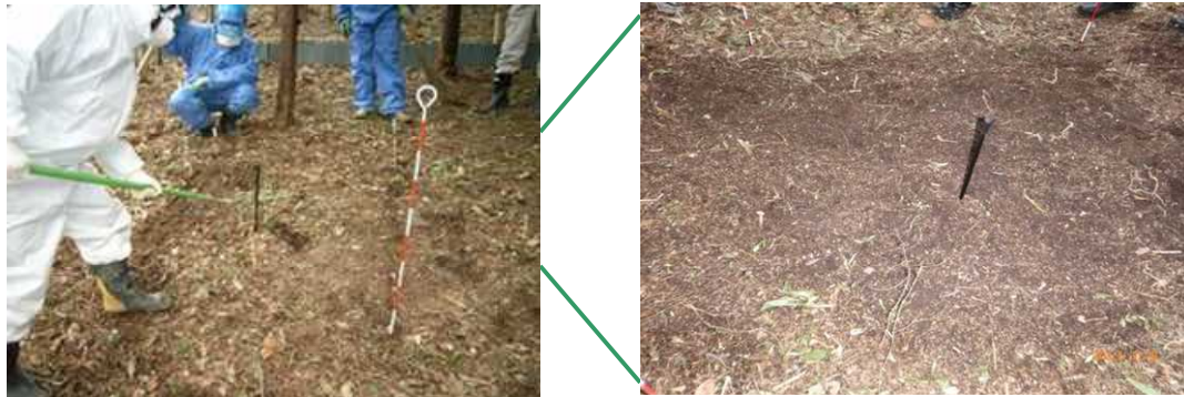
図 2-67 落葉等の堆積有機物除去の例
