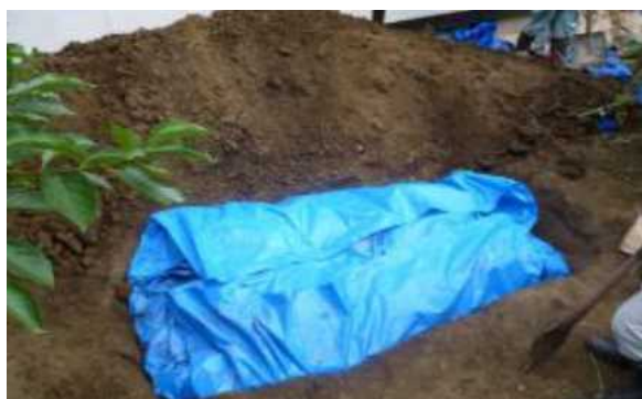
図4-6 現場保管（地下保管）例
