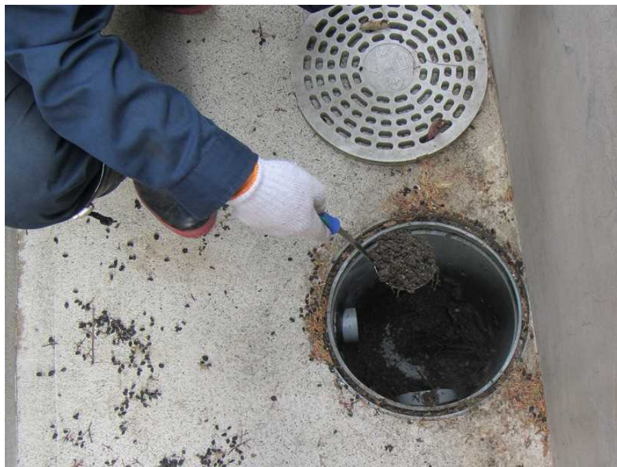
図 2-24 雨水枡の除染の例（堆積物の除去）
