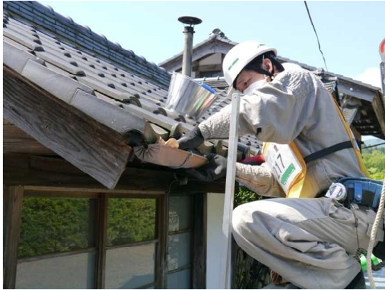
図 2-12 雨樋の除染の例（拭き取り）
