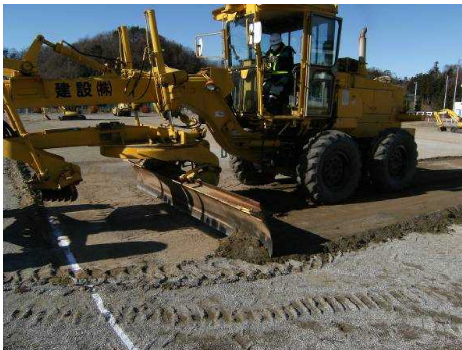
図 2-50 校庭の除染の例（表土の削り取り）
