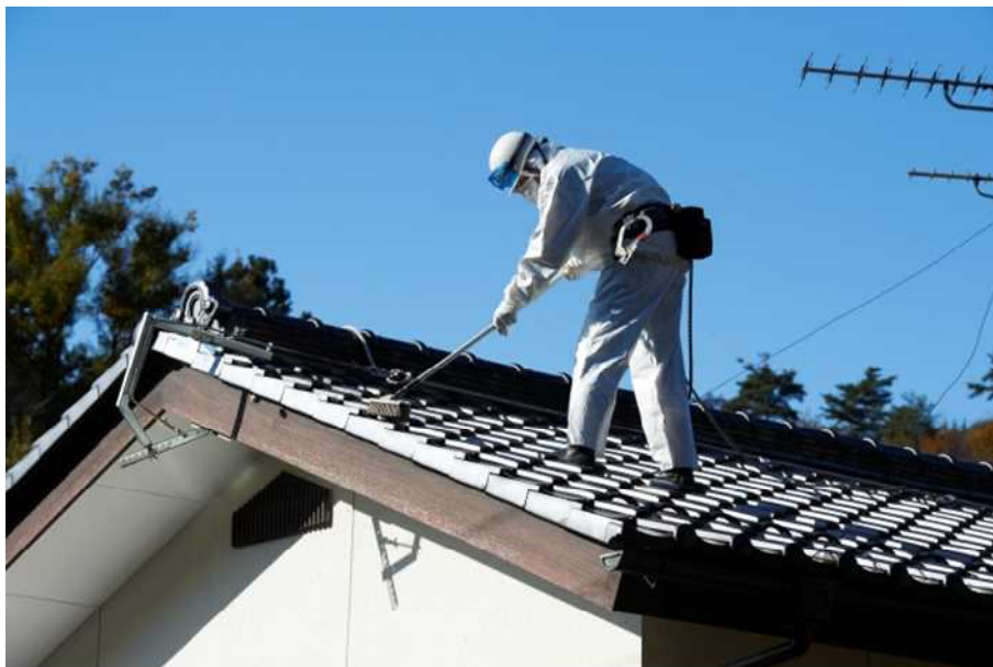
図 2-10 屋根の瓦の除染の例（洗浄）
