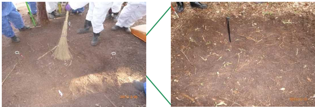
図 2-67 落葉等の堆積有機物除去の例
