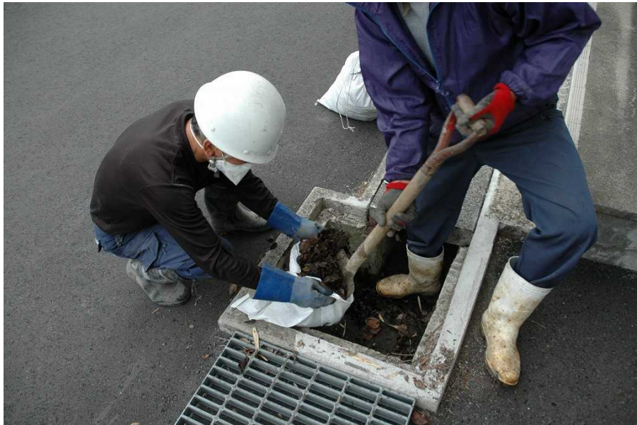
図 2-23 側溝の除染の例（堆積物の除去）
