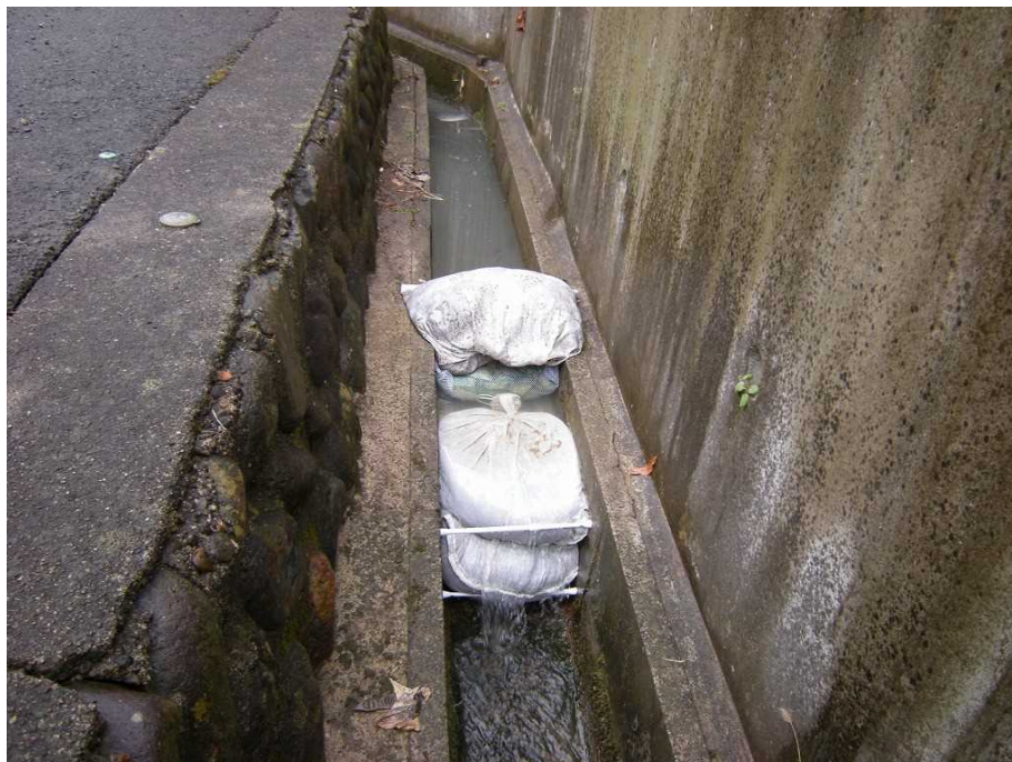
図 2-31 排水の処理の例（側溝に設置した土のう）
