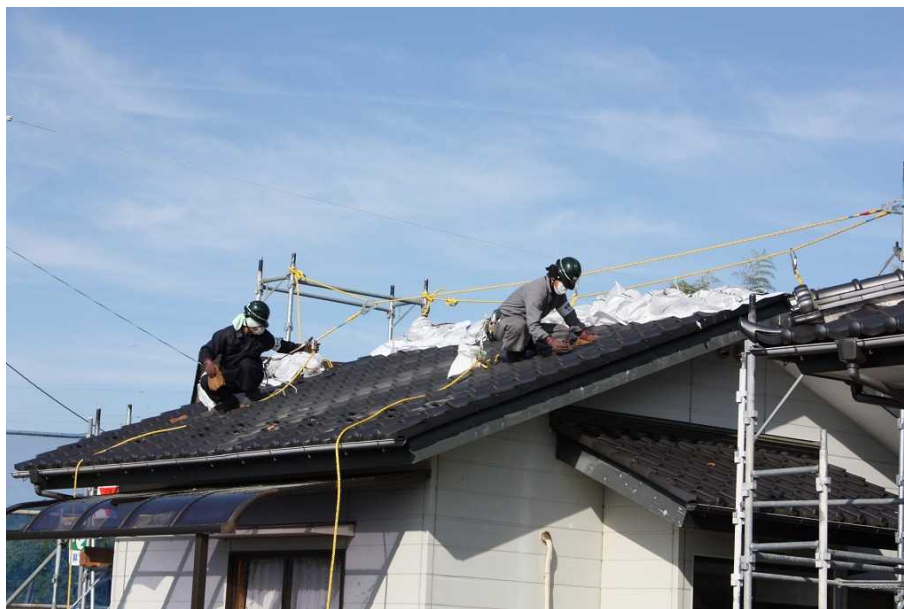
図2-9 屋根の瓦の除染の例（拭き取り）
