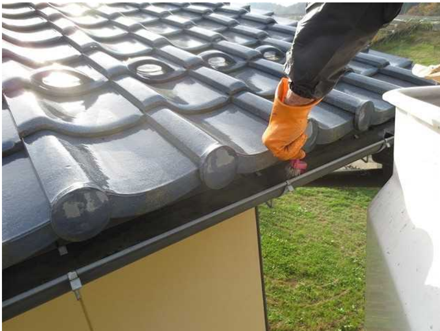
図 2-13 雨樋の除染の例（ブラシ洗浄）
