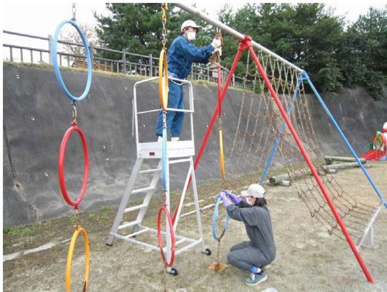
図 2-16 遊具の除染の例（拭き取り）
