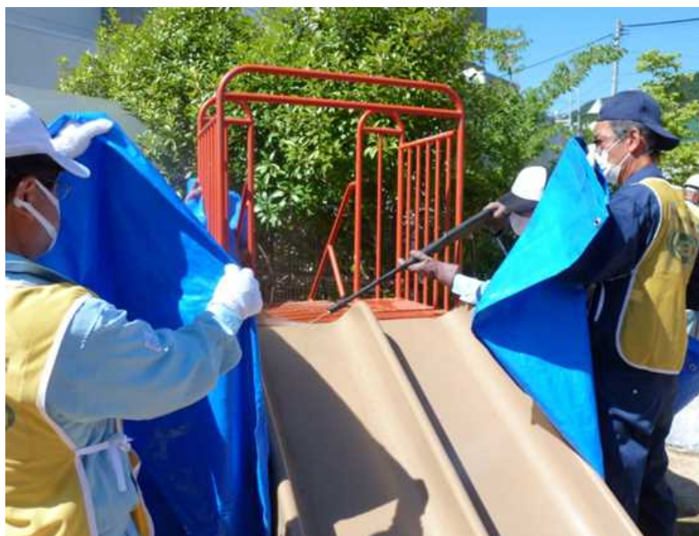
図 2-17 遊具の除染の例（高圧水洗浄）
