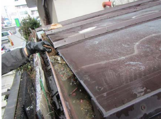
図 2-12 雨樋の除染の例（拭き取り）
