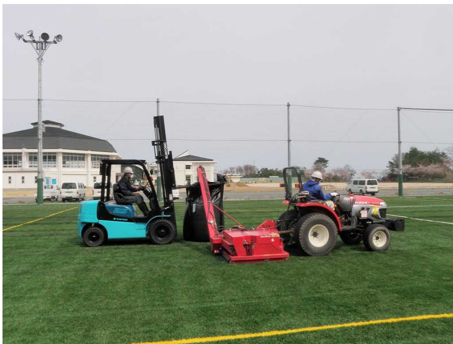
図 2-51 人工芝の充填材の除去の例
