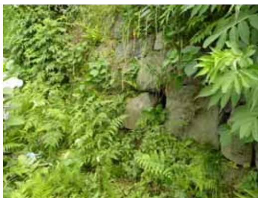
草本が繁茂する石垣
