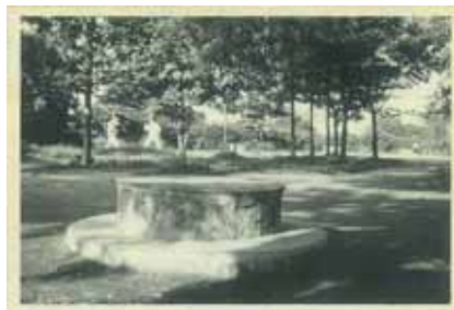
高射砲台の改修状況
